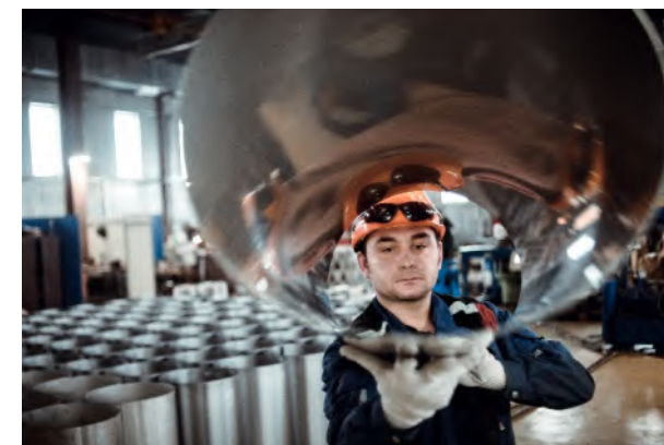
Контроль сварных швов
